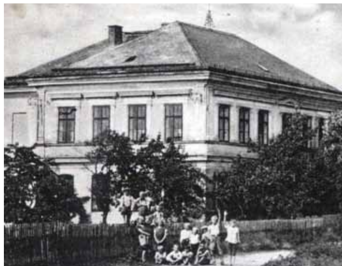
Místní škola kolem roku 1930, kdy v obci žilo přes 800 obyvatel
